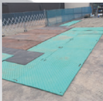
建設現場入口
